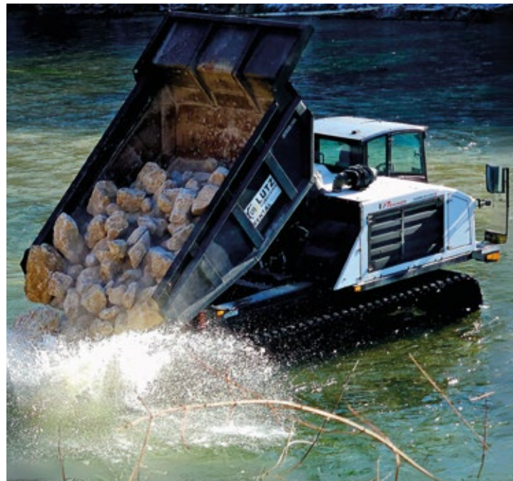
Foto: Marion Große-Sudhues; Flussmeisterstelle Freising
