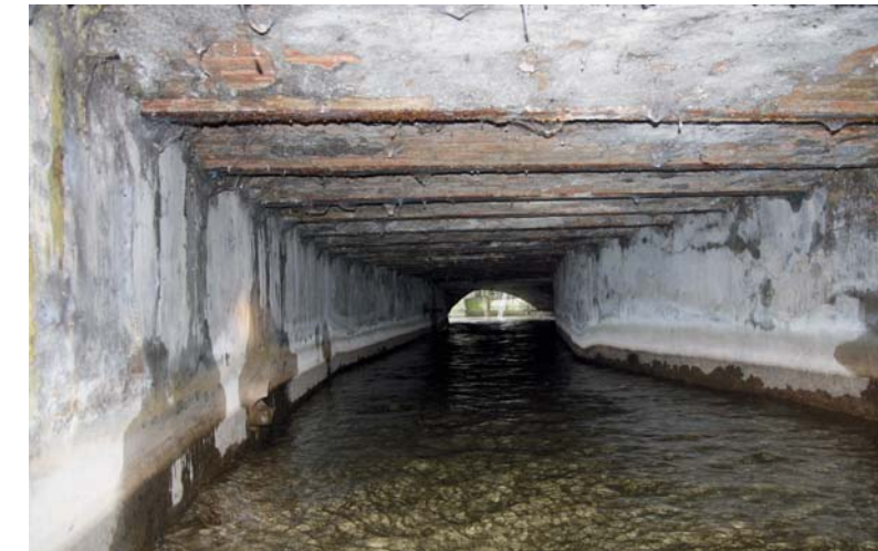
Abb. 16: Bei Bauarbeiten im Bereich der südlichen Überwölbung des Vorderen Lechs beim Kloster Maria Stern (im Bereich des Parkplatzes Beim Märzenbad) entstand 1995 eine Fotografie der Kanalüberwölbung (links). Abb. 17: Über eine weite Strecke wurde der südliche Vorplatz des Klosters Maria Stern mit einem preußischen Gewölbe (Befund 4) unterzogen – hier der Blick nach Süden entgegen der Fließrichtung.
