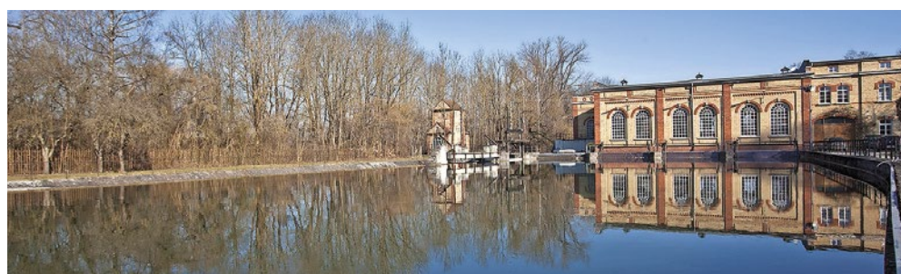
Das Wasserkraftwerk in der Wolfzahnau war bei seiner Inbetriebnahme 1902 das erste stromerzeugende Wasserkraftwerk im Stadtgebiet Augsburg.
